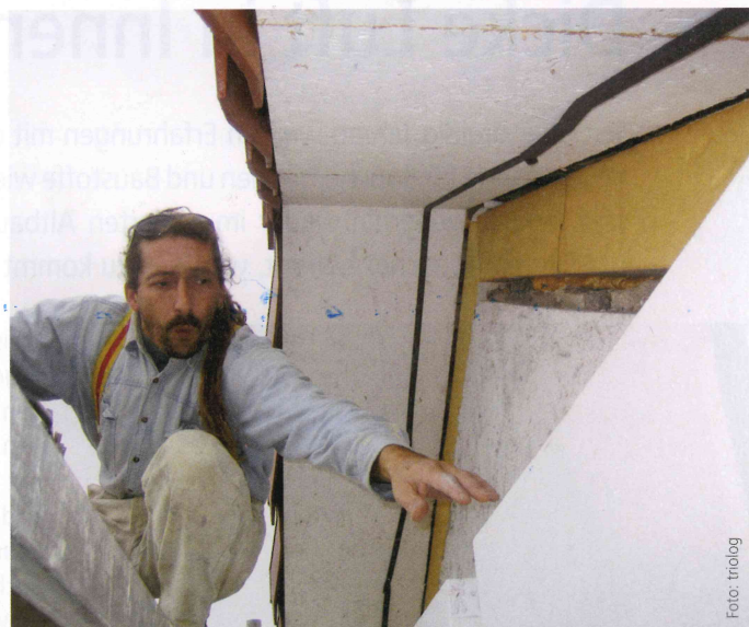
Außendämmung mit Wärmedämmverbundsystem – Styropor ist besser als sein Ruf.
