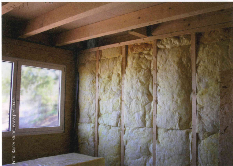
Zwischensparrendämmung – so bleibt die Heizenergie unter Dach und Fach
