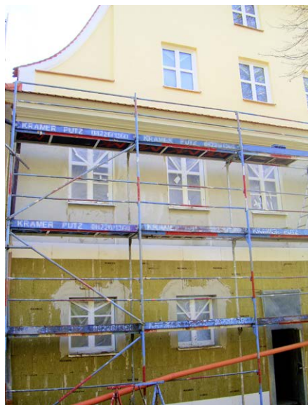
(3) Brauereigasthof Autenried während der Sanierung: Auf Teile der Fassade wurden bis zu 16 cm eines mineralischen Wärmedämm-Verbundsystems aufgebracht.
